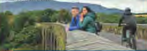
L'un des trois viaducs de la Waterford Greenway (voie verte de Waterford).
